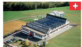
Siège HOPPE AG, Müstair
